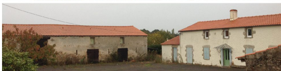
David Peneau au centre des Logis du château, l'avant et l'après du projet de réhabilitation qui a consisté à transformer une ancienne ferme d'Aigrefeuille-sur-Maine en sept logements.
